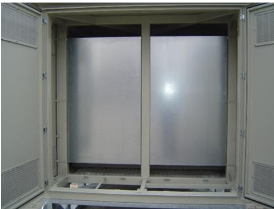
Простор за смештај НН опреме и простор за смештај трансформатора
